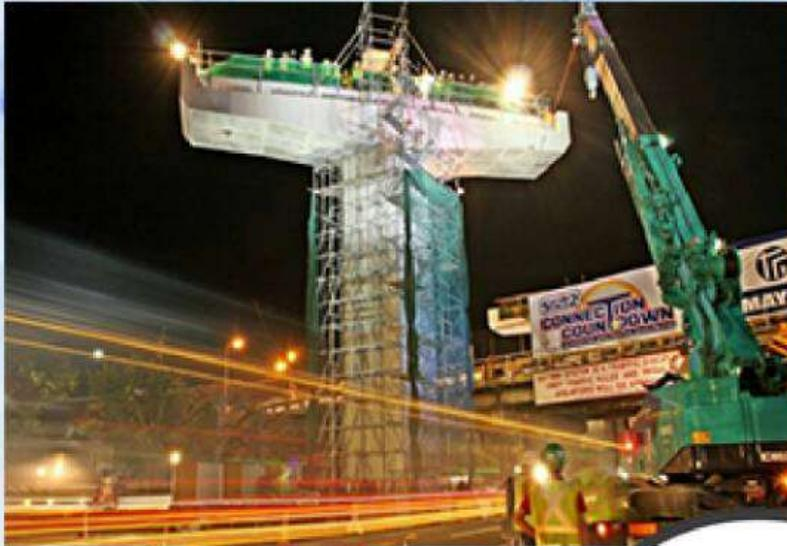
Teknik Sosrobahu adalah teknik konstruksi yang digunakan untuk memutar bahu lengan beton jalan layang.
